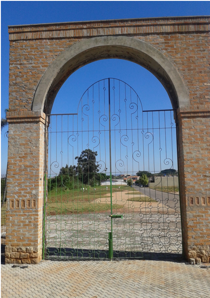
Portal do JBIVB feito com tijolos de demolição.
